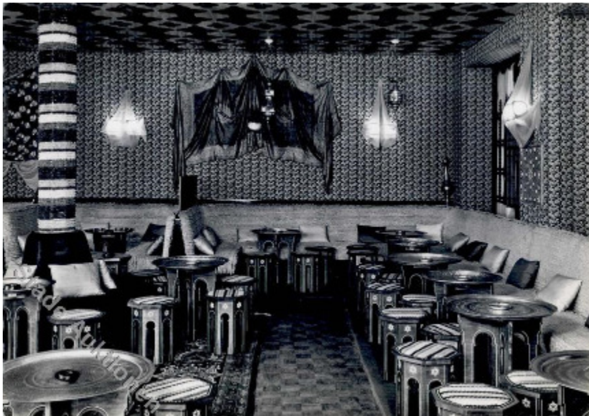
Ehem. Café Türck [!], Kirchgasse 3, 8001 Zürich (o.J.)
